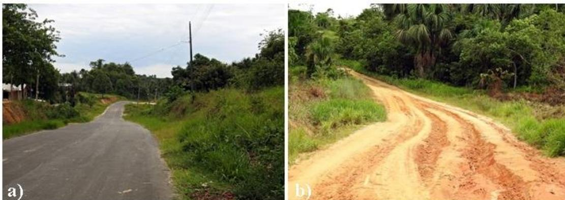
Figura 6. Trechos do ramal Pentecoste: a) trecho com malha asfáltica; b) trecho não asfaltado no alto Pentecoste.
