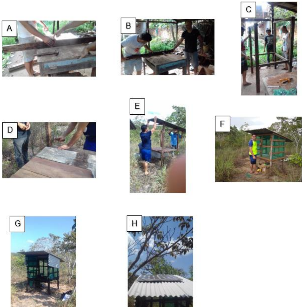
Figura 26. (A) e (B) Dimensionamento e corte das ripas de madeira, (C) Montagem da estrutura do abrigo, (D) Confeção do assoalho, (E) Instalação da telha, (F) Persiana e tela colocadas, para prevenir entrada de mosquitos, (G) Óleo queimado aplicado para prevenir ação de cupins e (H) Painéis solares instalados sobre o abrigo.
